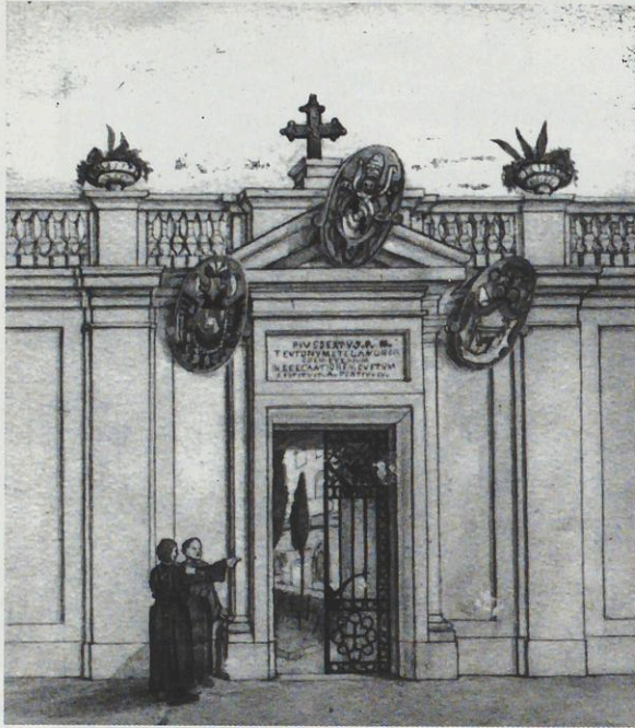
Kat. 34 Ansicht des Campo Santo Teutonico, 2. Hälfte 19. Jh.; ACST.
