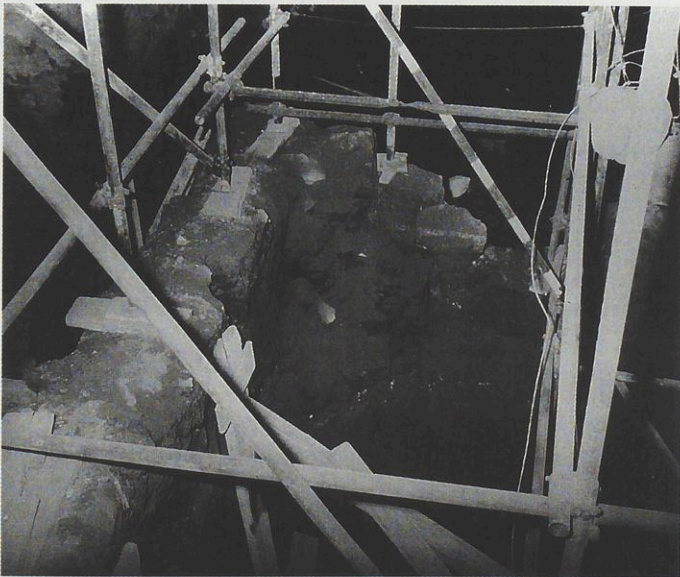
Abb. 12 Verlauf der gleichen Mauer in Ost-Westrichtung. Aufnahme 1971.
