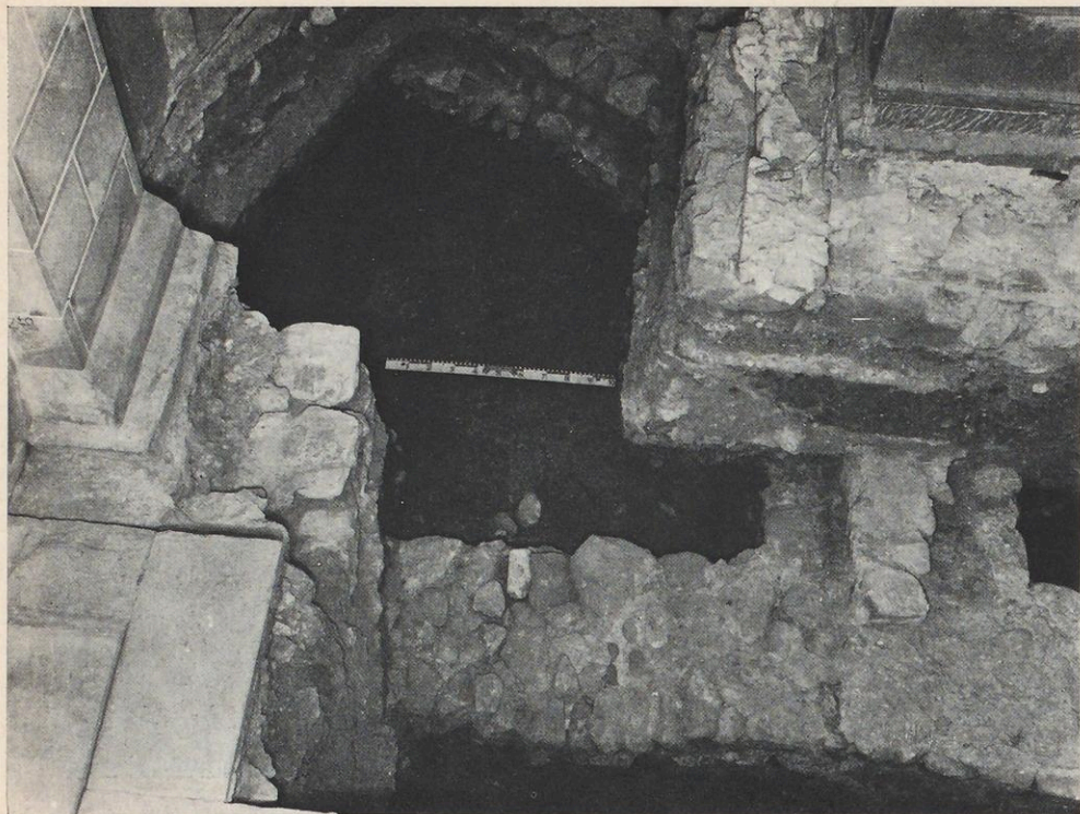
a) Reichenau-Niederzell, Apsis und Spannfundament des Baues I im bestehenden Chor
