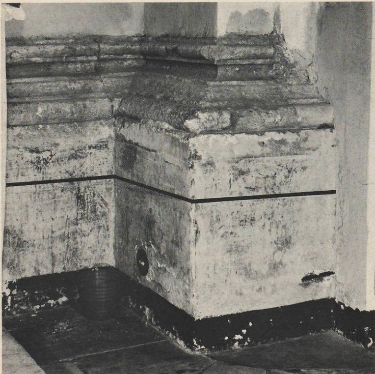
b) Sockel des Bramante-Schutzhauses in den Grotten von St. Peter; schwarze Linie: Bodenniveau von Alt-St. Peter
