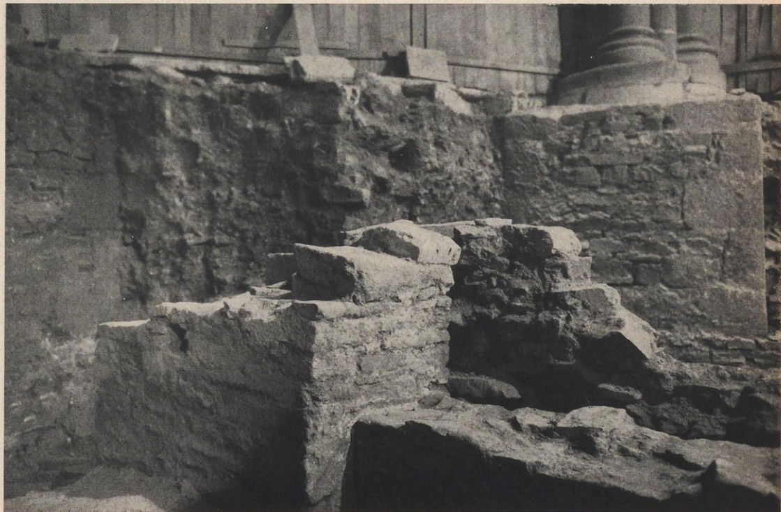
b) Südwest-Ecke der Thermen-Anlage (mit Bogenansatz)
