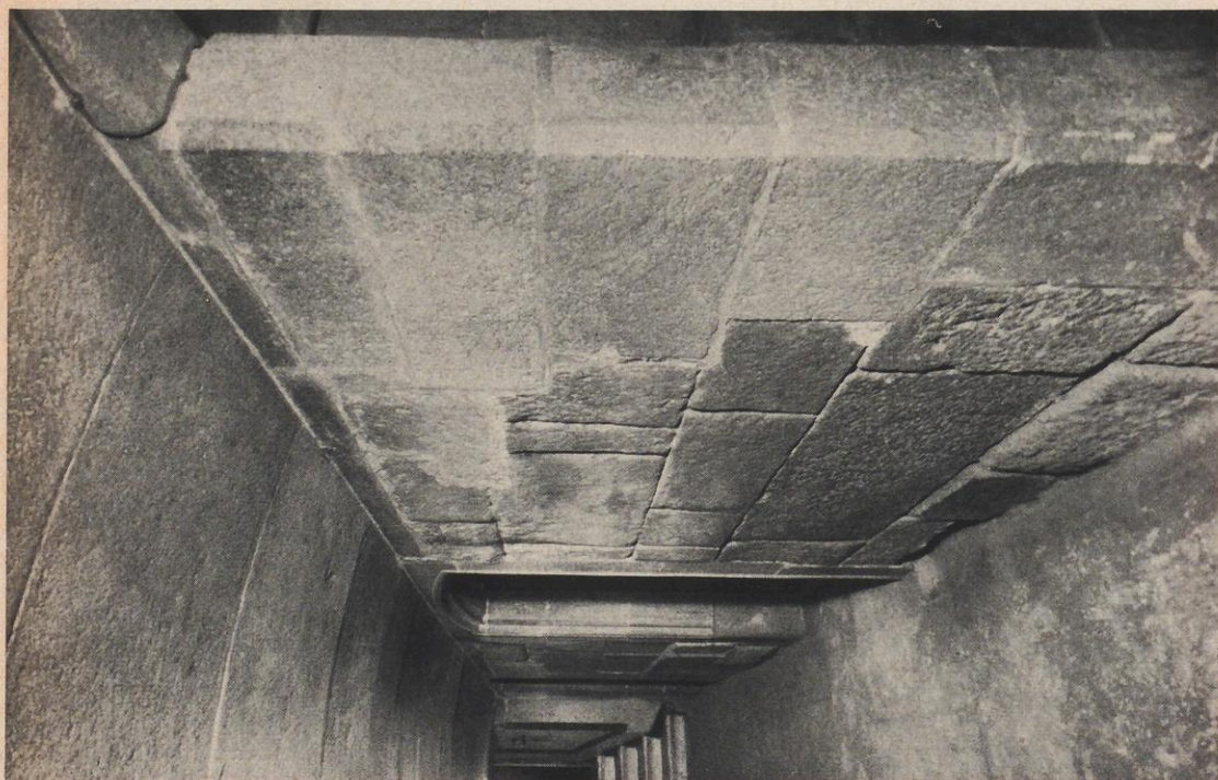
a) Die Westseite des römischen Mausoleums
